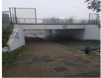
Het tunneltje waar de kosmopoliet zat.
